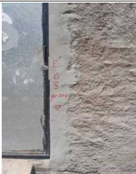
Figura 1: Marcação Topográfica.
