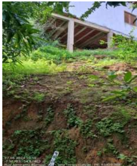
Figura 3: Barreira Antes da Capinação.
