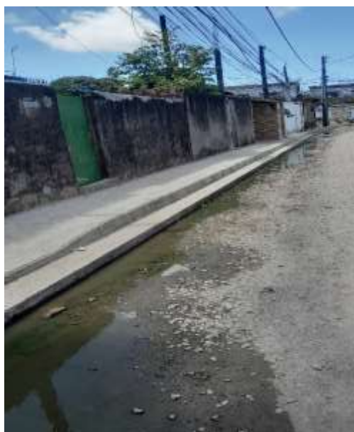
Figura 4: Execução de Calçada,
