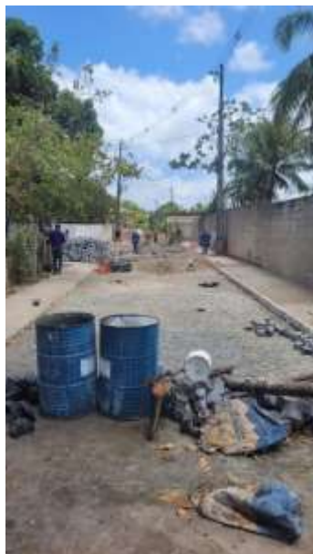
Figura 6: Canteiro de obras
