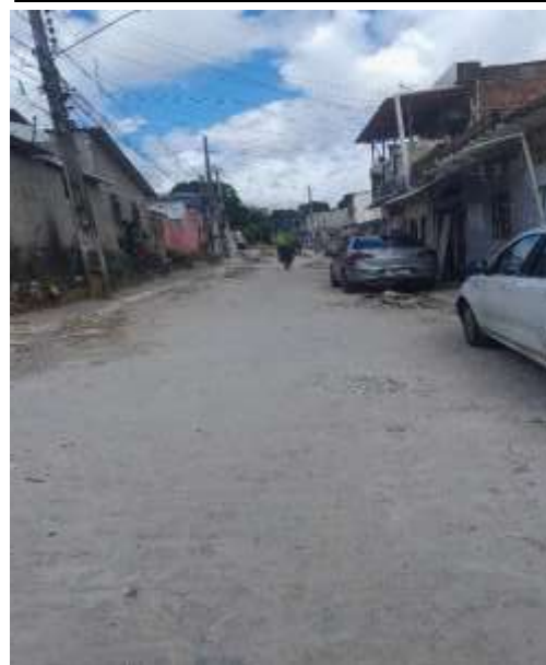
Figura 3: Pavimentação da Rua.
