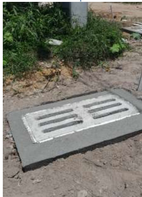
Figura 10: Construção de Sarjeta com tampa
