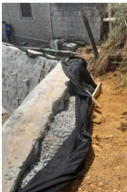
Figura 11: Reforço no Muro de Contenção.
