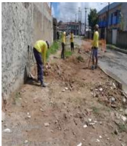
Figura 4: capinação de Terreno.
