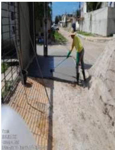
Figura 6: Concretagem de Calçada
