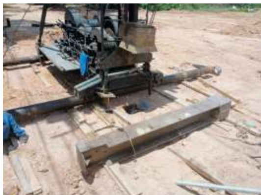
Figura 2: Execução estaca metálica
