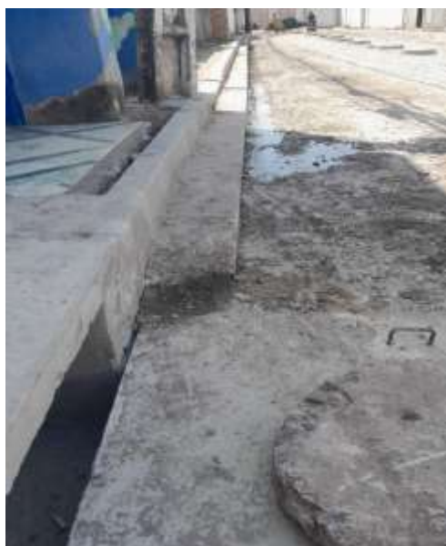
Figura 4: Meio-Fio e Linha D'Água.
