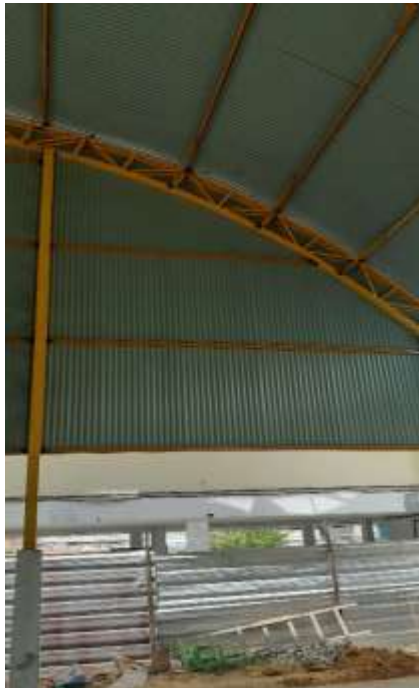
Figura 3: Tapume com Telhas Metálicas
