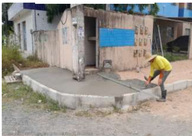
Figura 11: Calçada, Meio-fio e sarjeta.
