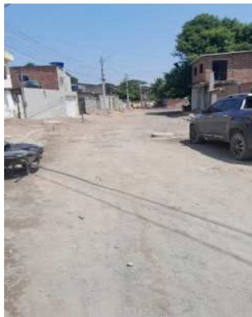
Figura 7: Regularização de Terreno.
