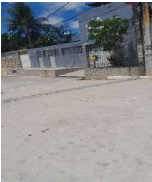
Figura 2: Pavimentação da Rua.
