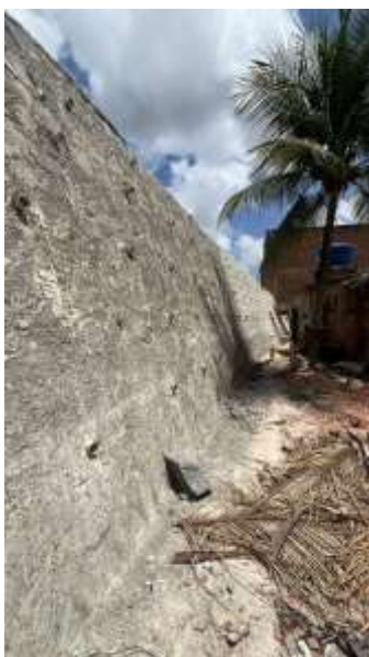
Figura 4: Drenagem do muro.
