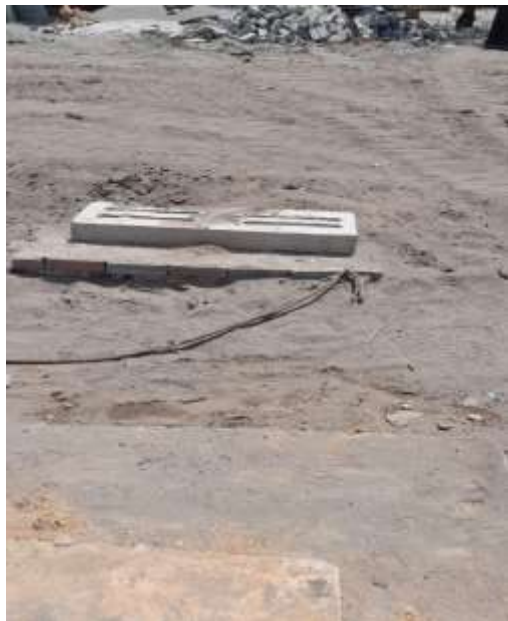
Figura 4: Meio-Fio e Linha D'Água.
