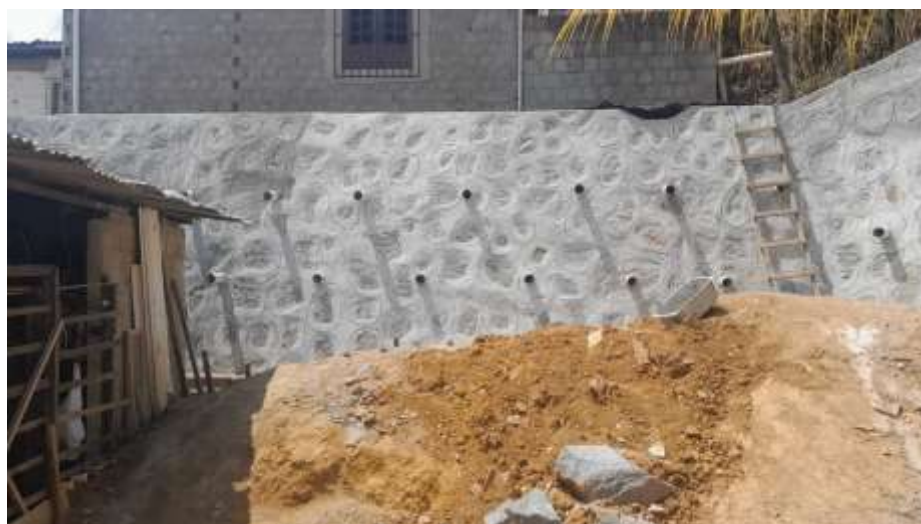
Figura 10: Muro de Contenção.
