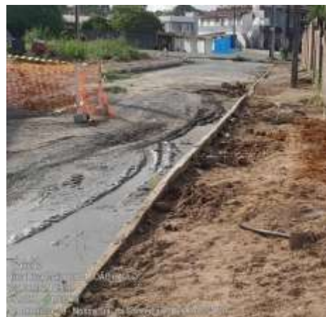
Figura 5:regularização de terreno e Meio-Fio
