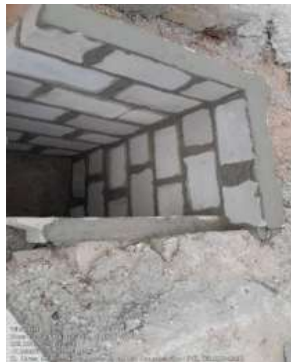
Figura 8: construção de Sarjeta
