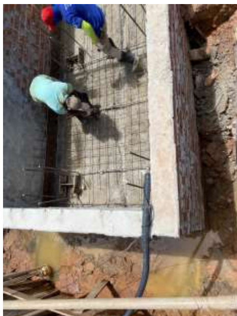
Figura 6: Armação bloco de fundação
