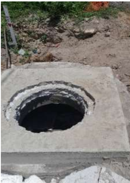
Figura 9: Caixa Coletora
