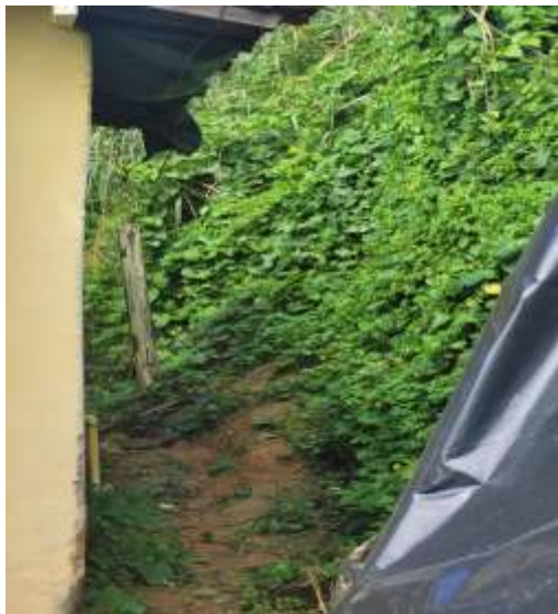
Figura 2: Barreira Antes da Capinação.
