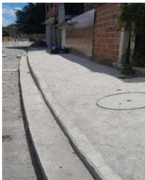
Figura 5: Execução de Meio-Fio .
