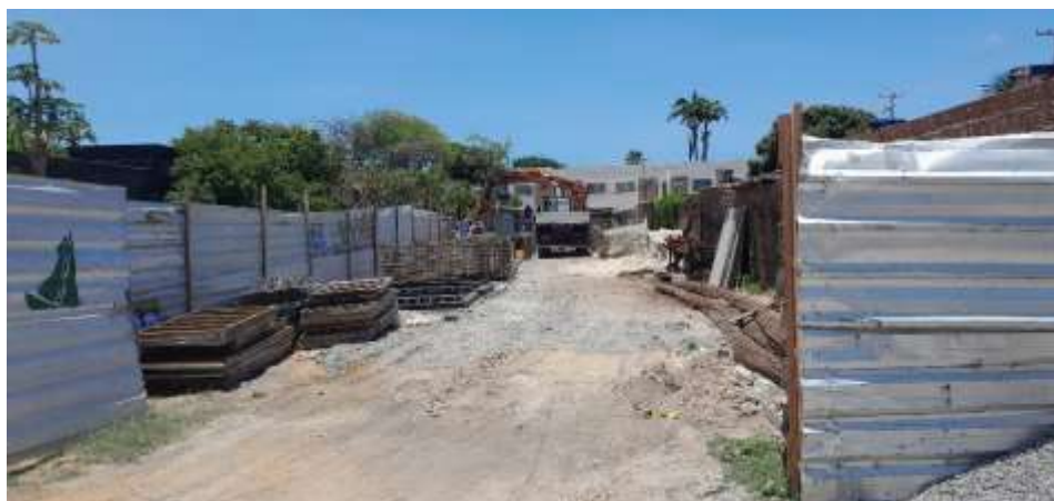
Figura 6: Tapume em Canteiro de Obra
