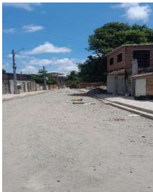
Figura 3: Regularização de Terreno.
