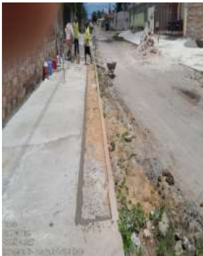
Figura 7:Execução de Calçadas
