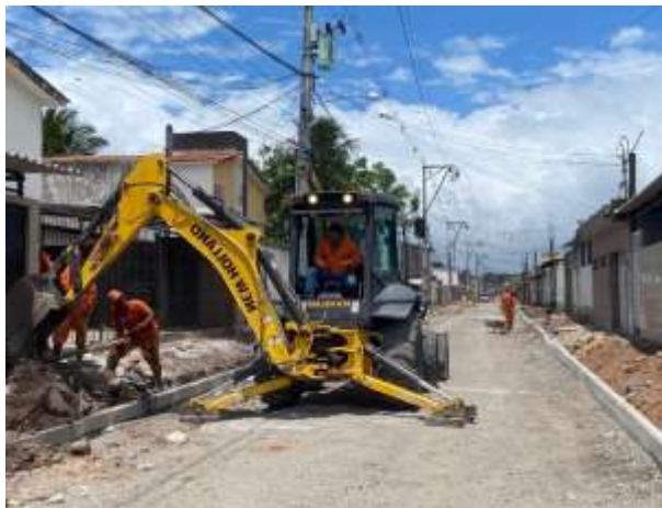
Figura 6: Execução Calçada e base
