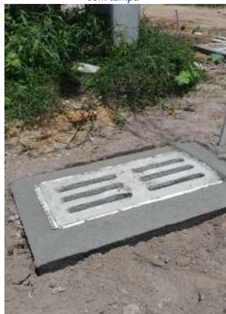
Figura 10: Construção de Sarjeta com tampa
