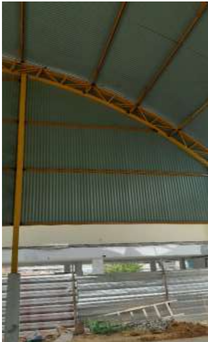
Figura 3: Tapume com Telhas Metálicas
