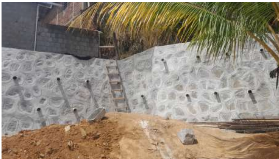
Figura 9: Muro de Contenção.
