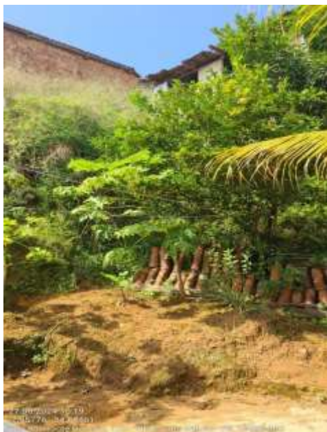
Figura 6: Barreira Antes da Capinação.
