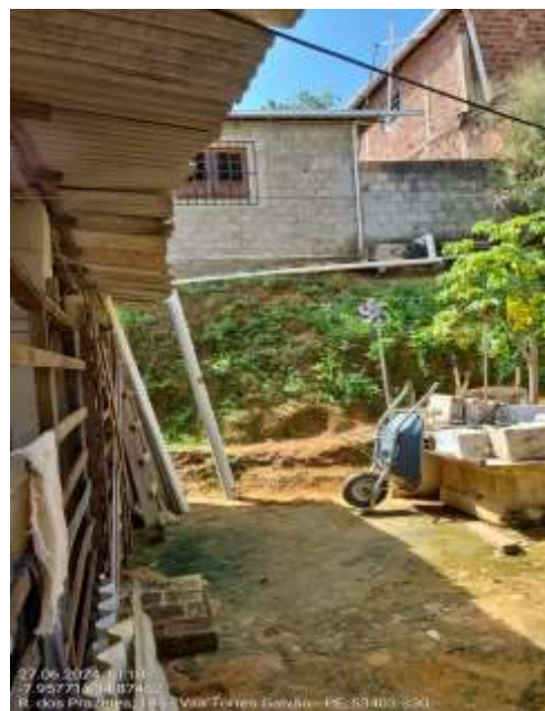
Figura 7: Barreira Antes da Capinação.
