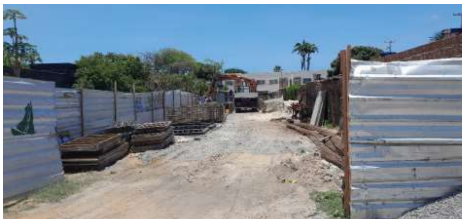
Figura 6: Tapume em Canteiro de Obra
