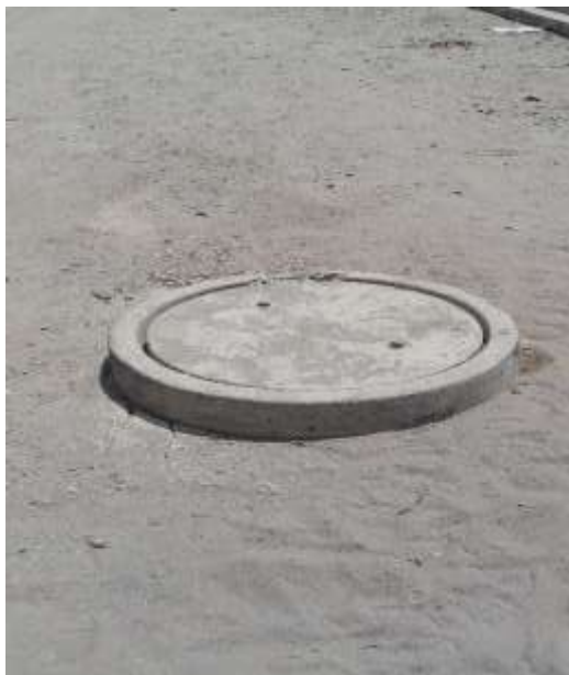
Figura 2: Caixa Coletora..
