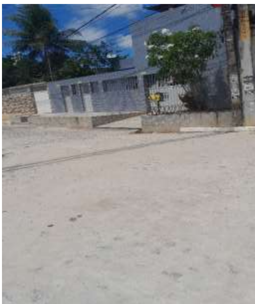
Figura 2: Pavimentação da Rua.
