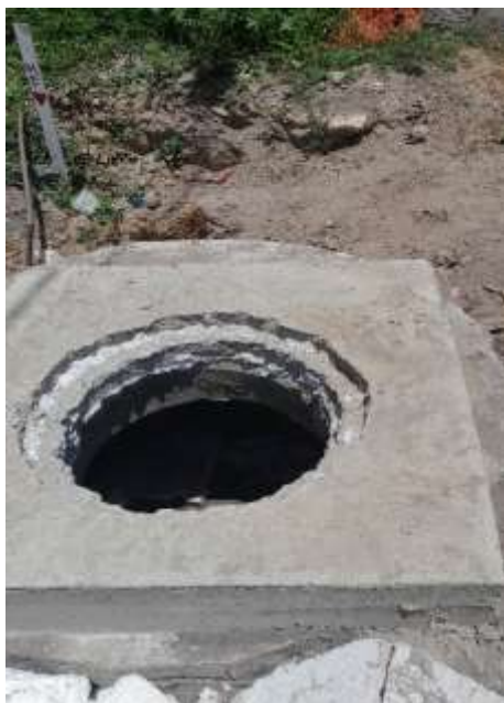
Figura 9: Caixa Coletora
