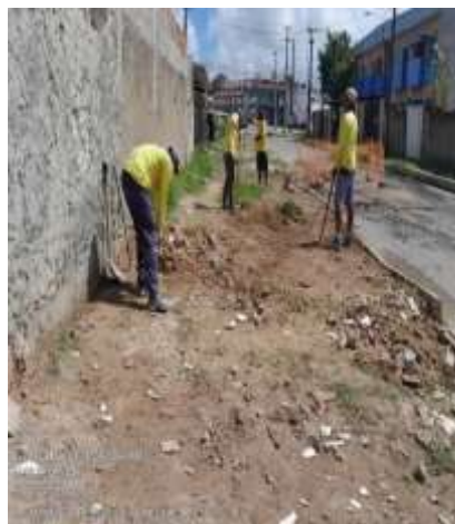
Figura 4: capinação de Terreno.
