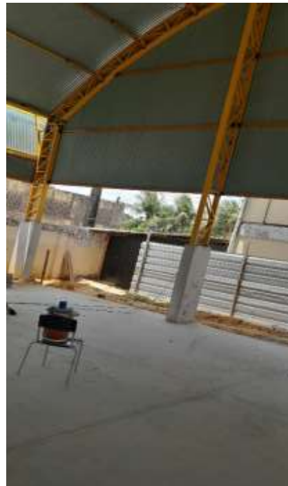
Figura 4: Piso em Concreto, Concretagem dos Pilares Metálicos e Aterro.
