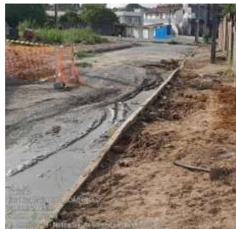
Figura 5:regularização de terreno e Meio-Fio
