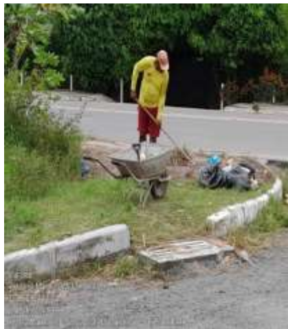
Figura 3: Capinação de Terreno
