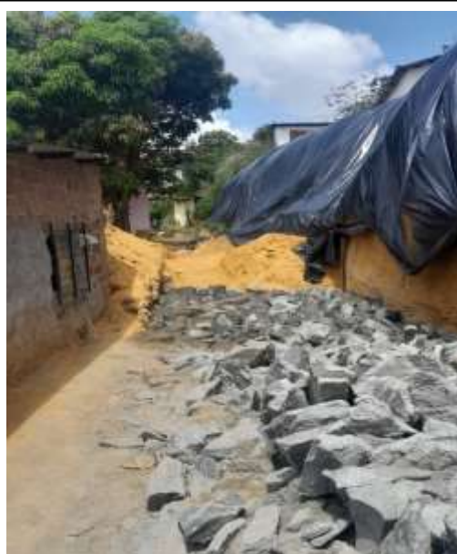
Figura 5: Base do Muro.
