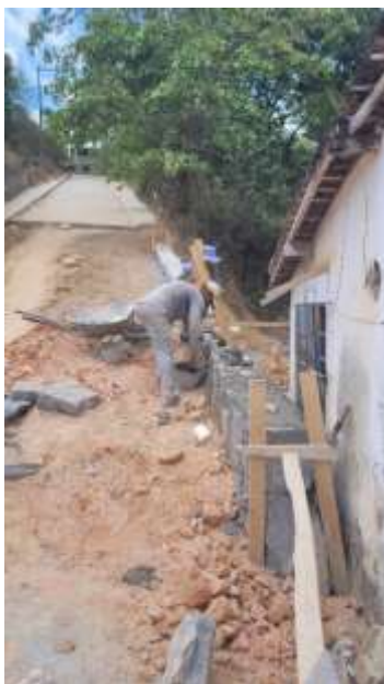
Figura 4: Drenagem do muro.
