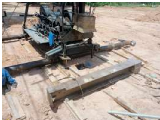
Figura 2: Execução estaca metálica
