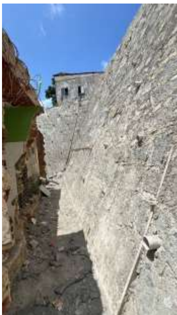
Figura 4: Drenagem do muro.
