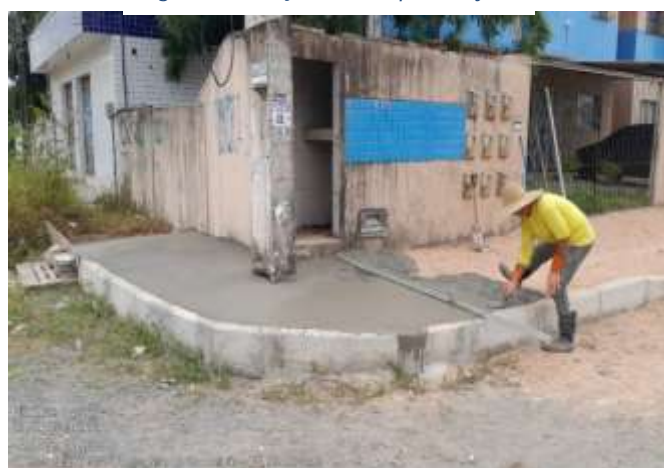
Figura 11: Calçada, Meio-fio e sarjeta.
