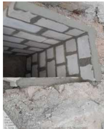
Figura 8: construção de Sarjeta
