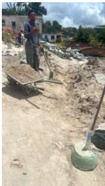
Figura 6: Canteiro de obras
