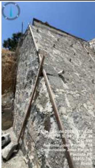
Figura 1: Execução muro de arrimo
