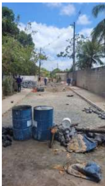
Figura 6: Canteiro de obras
