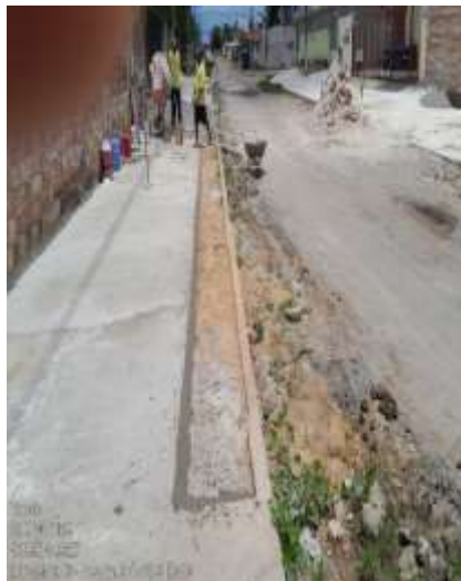
Figura 7:Execução de Calçadas
