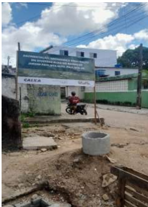
Figura 1: Placa de Obra.
