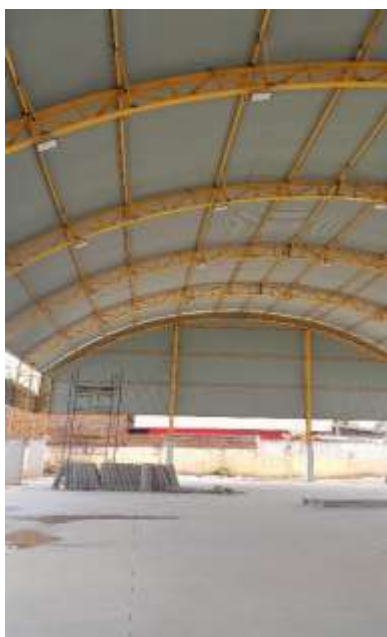
Figura 1: Coberta da Quadra Poliesportiva.
