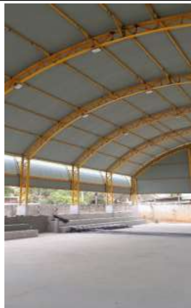
Figura 2: Construção da Arquibancada e Pintura da Estrutura Metálica.
