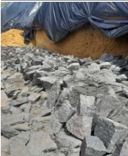
Figura 4: Base do Muro.
