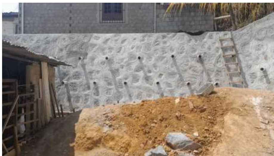
Figura 10: Muro de Contenção.
