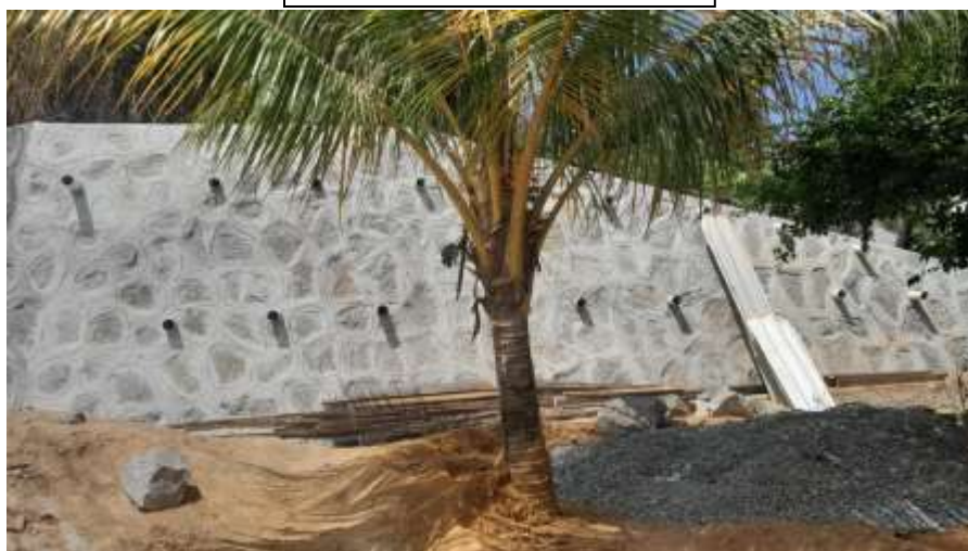
Figura 8: Muro de Contenção.
