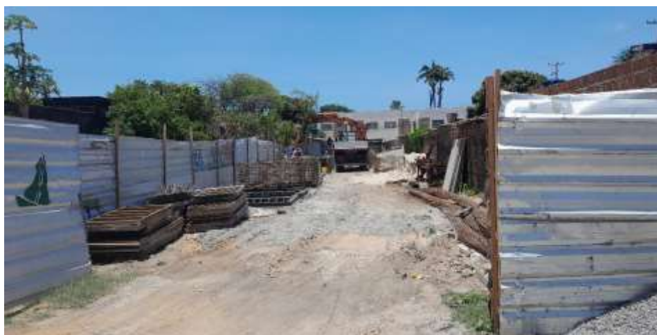
Figura 7: Canteiro de Obra
