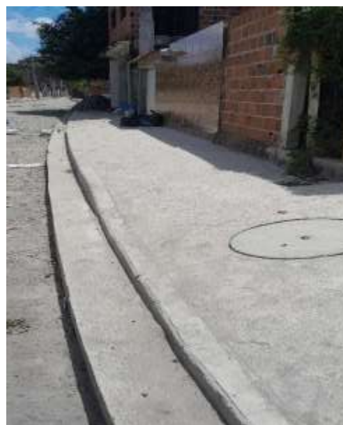
Figura 5: Execução de Meio-Fio .
