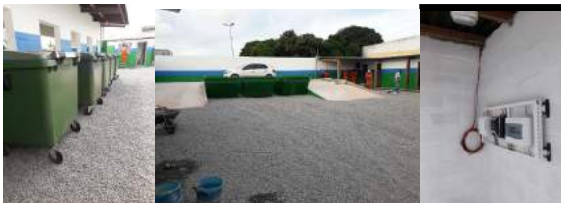
Figura 07 – Eco-ponto localizado na Av. Brasil – Maranguape I, concluído e entregue ao município pela concessionária
