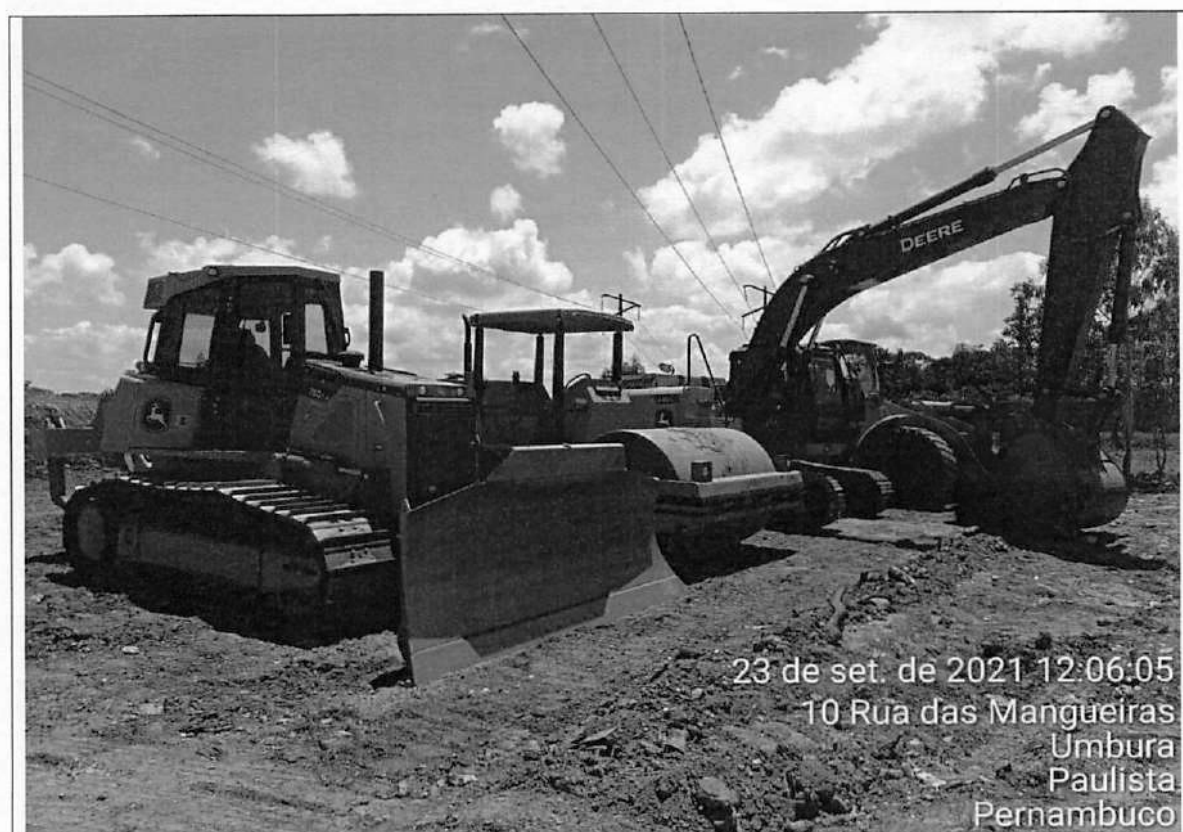
Figura 7 – Máquinas utilizadas na operação do Aterro de Inertes e e Unidade de Transbordo
