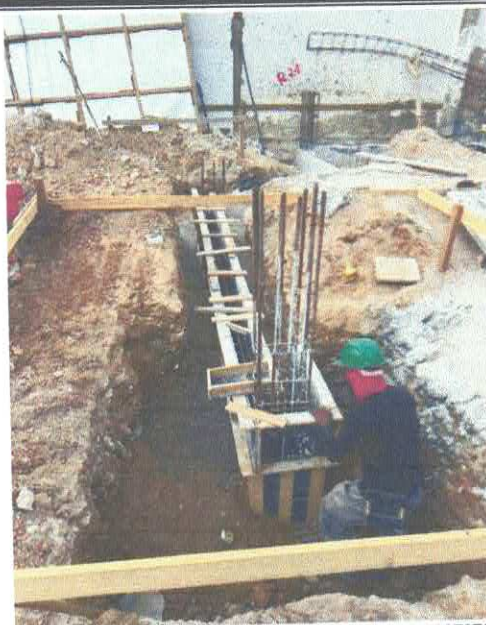
FOTO 14: ARMAÇÃO DE BLOCO, VIGA BALDRAME E PILAR UTILIZANDO AÇO CA-60 DE 5 MM.
