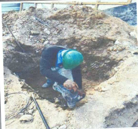
FOTO 04: ESCAVAÇÃO MANUAL PARA BLOCO DE COROAMENTO OU SAPATA (INCLUINDO ESCAVAÇÃO PARA COLOCAÇÃO DE FÔRMAS).
