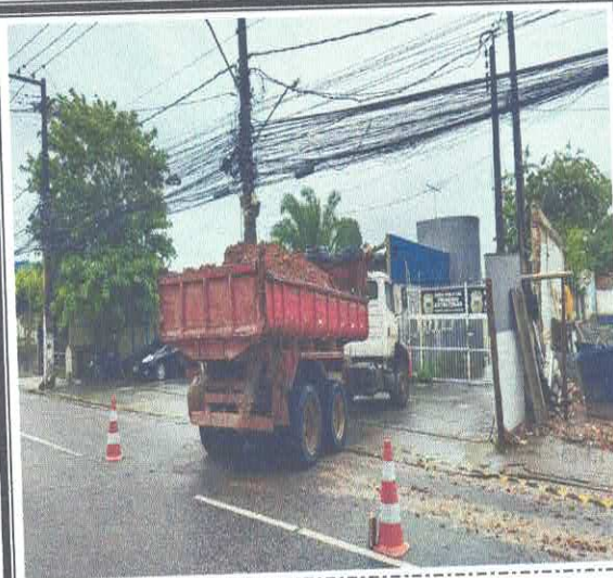
FOTO 03: CARGA, MANOBRA E DESCARGA DE ENTULHO EM CAMINHÃO BASCULANTE 10 M 3 .
