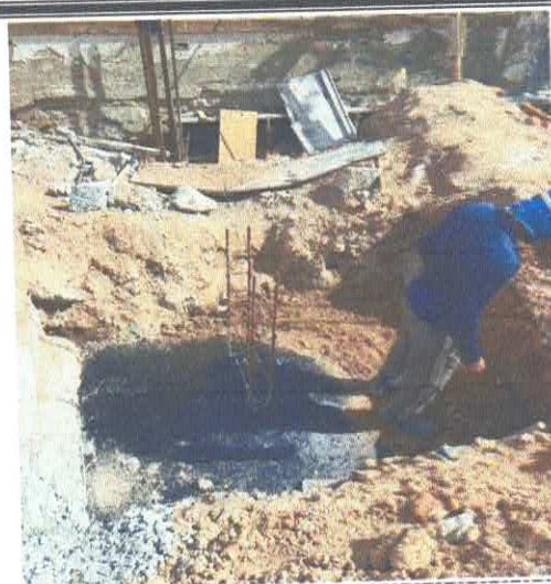
FOTO 16: IMPERMEABILIZAÇÃO DE SUPERFÍCIE COM EMULSÃO ASFÁLTICA, 2 DEMÃOS.
