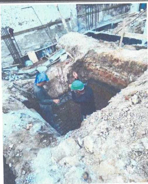
FOTO 13: ARMAÇÃO DE BLOCO, VIGA BALDRAME OU SAPATA UTILIZANDO AÇO CA-50 DE 12,5 MM.
