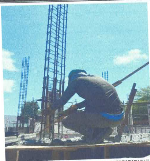
FOTO 19: ARMAÇÃO DE PILAR OU VIGA DE ESTRUTURA CONVENCIONAL DE CONCRETO ARMADO UTILIZANDO AÇO CA-50 DE 16,0 MM.
