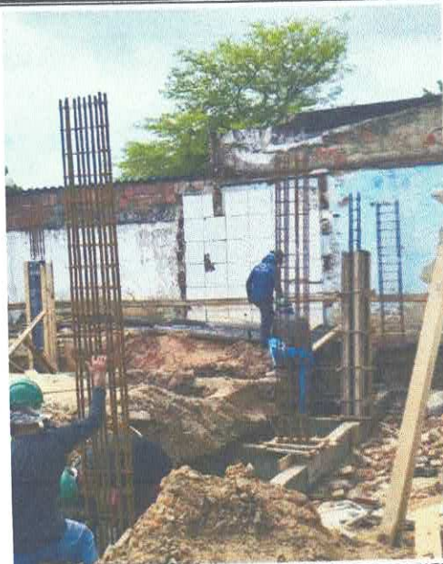
FOTO 18: ARMAÇÃO DE PILAR OU VIGA DE ESTRUTURA CONVENCIONAL DE CONCRETO ARMADO UTILIZANDO AÇO CA-50 DE 12,5 MM.
