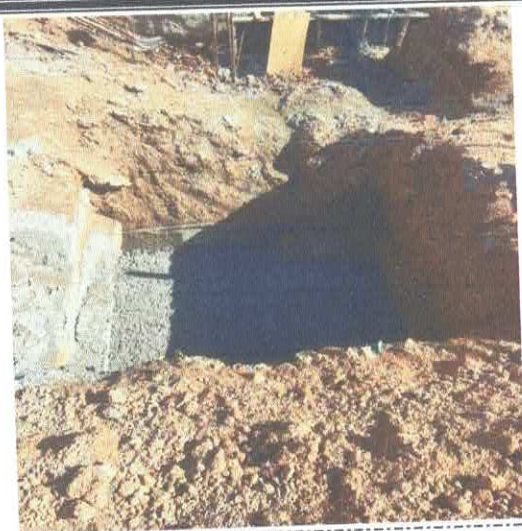
FOTO 11: LASTRO DE CONCRETO MAGRO, APLICADO EM BLOCOS DE COROAMENTO OU SAPATAS, ESPESSURA DE 5 CM.
