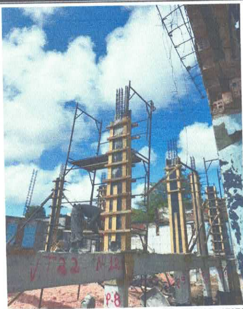
FOTO 17: FABRICAÇÃO DE FÔRMA PARA PILARES E ESTRUTURAS SIMILARES, EM CHAPA DE MADEIRA COMPENSADA RESINADA, E = 17 MM.
