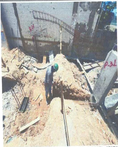
FOTO 05: ESCAVAÇÃO MANUAL DE VALA PARA VIGA BALDRAME (INCLUINDO ESCAVAÇÃO PARA COLOCAÇÃO DE FÔRMAS).
