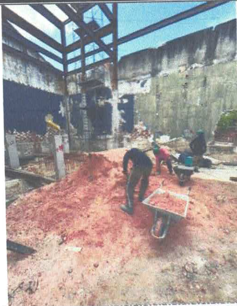
FOTO 02: ATERRO MANUAL DE VALAS COM AREIA PARA ATERRO E COMPACTAÇÃO MECANIZADA.
