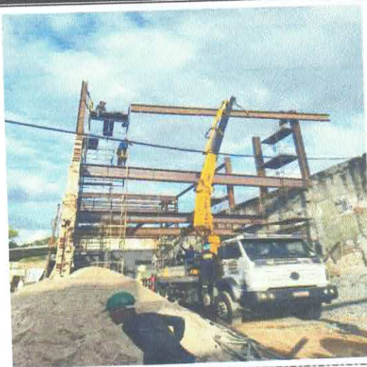
FOTO 24: VIGA METÁLICA EM PERFIL LAMINADO OU SOLDADO EM AÇO ESTRUTURAL, COM CONEXÕES SOLDADAS, INCLUSIVE MÃO DE OBRA, TRANSPORTE E IÇAMENTO UTILIZANDO GUINDASTE - FORNECIMENTO E INSTALAÇÃO.
