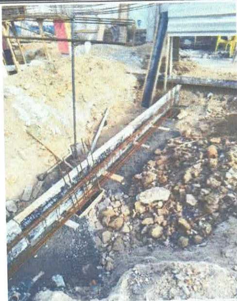
FOTO 10: ARMAÇÃO DE BLOCO, VIGA BALDRAME OU SAPATA UTILIZANDO AÇO CA-50 DE 10 MM.
