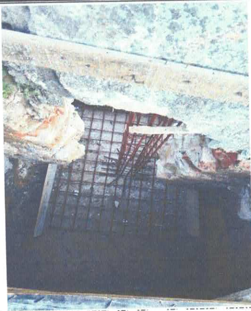
FOTO 09: ARMAÇÃO DE BLOCO, VIGA BALDRAME OU SAPATA UTILIZANDO AÇO CA-50 DE 8 MM.
