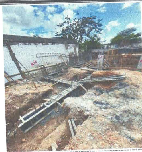
FOTO 12: FABRICAÇÃO, MONTAGEM E DESMONTAGEM DE FÔRMA PARA VIGA BALDRAME, EM CHAPA DE MADEIRA COMPENSADA RESINADA, E=17 MM, 4 UTILIZAÇÕES.
