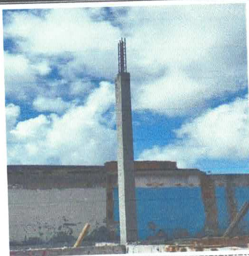
FOTO 20: CONCRETO SIMPLES USINADO FCK=35MPa, BOMBEADO, LANÇADO E ADENSADO EM SUPERESTRUTURA.
