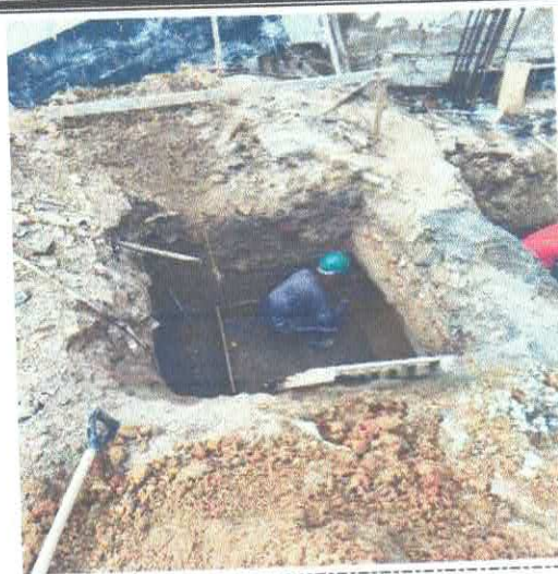
FOTO 08: FABRICAÇÃO, MONTAGEM E DESMONTAGEM DE FÔRMA PARA SAPATA, EM CHAPA DE MADEIRA COMPENSADA RESINADA, E=17 MM, 4 UTILIZAÇÕES.
