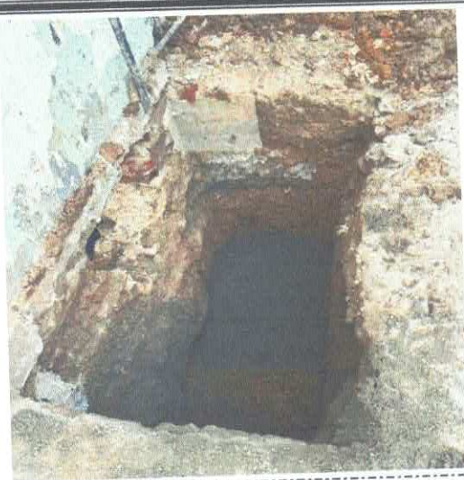
FOTO 07: SOLO-CIMENTO COMPACTADO - TRAÇO 1:20, INCLUSIVE CIMENTO E AREIA.
