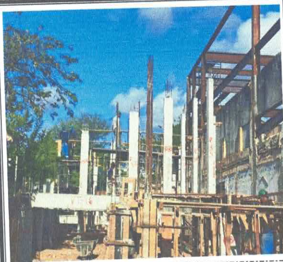
FOTO 23: CONCRETO SIMPLES USINADO FCK=35MPa, BOMBEADO, LANÇADO E ADENSADO EM SUPERESTRUTURA.
